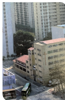
深浸重建前舊堂
